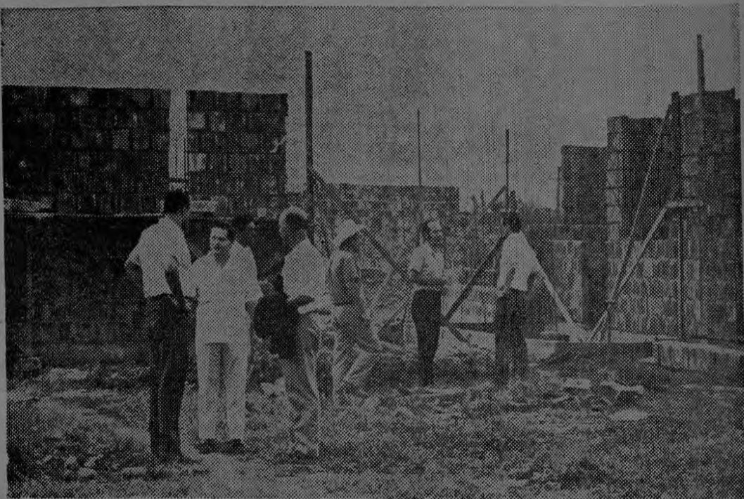
DISPENSARIO DE RIO FRIO. — La gráfica nos muestra el grado de avance de la construcción del Dispensario de Río Frío, obra que tiene un costo de ₡ 1.500.000. Se observan varios funcionarios de la Caja Costarricense de Seguro Social cuando inspeccionaban la construcción, durante la visita que hicieron recientemente por varios lugares de la zona atlántica.
